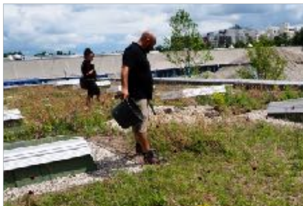
Pflegeinsatz mit Firma Stoewahs auf dem oberen Dach Postweg 97b.
