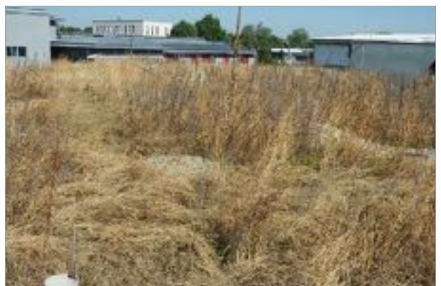
2. Saison, August. Jetzt hat die Hitze auch die Vegetation auf diesem Dach vertrocknen lassen. Bereits im September wird es aber wieder neu austreiben.
