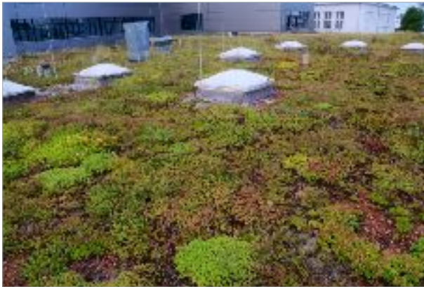
Vorher. Dieses Dach wies ebenfalls nur eine geringe Substrathöhe auf. Dadurch konnten nur Mauerpfefferarten wachsen.
