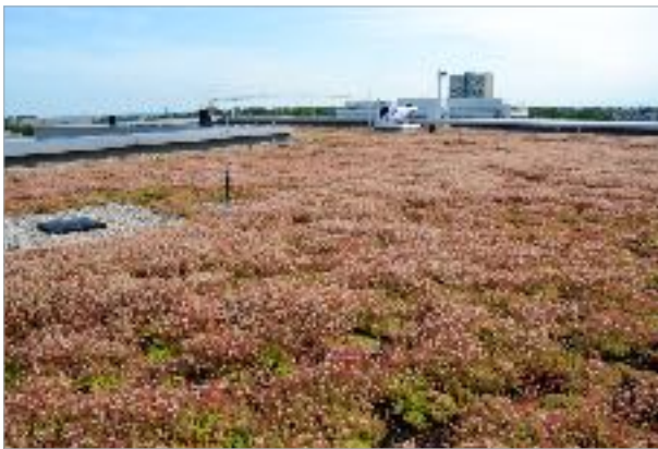
Vorher: Nur 8 cm Intensivsubstrat reichen nicht in Zeiten des Klimawandels. Die ganze Fläche wird um weitere 7 cm erhöht.
