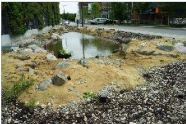
Versickerungsfläche am Parkhaus. Ein optischer Hingucker. Regenwasser vom Dach wird hier auch als Gestaltungselement eingesetzt und verbessert gleichzeitig das Kleinklima.
