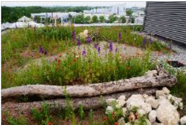
1. Saison, Juni. Dieses Dach wurde mit Intensiv-Dachsubstrat komplett neu angelegt. Hervorragende Entwicklung.
